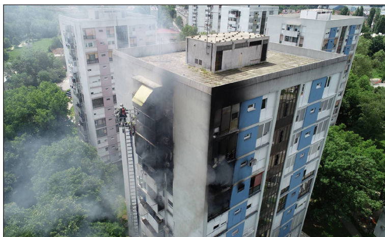
Požar stana (Dron JVP Zagreb, arhiva)
